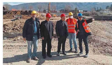
Amatrice In alto il sopralluogo al cantiere. Sotto il progetto definitivo
