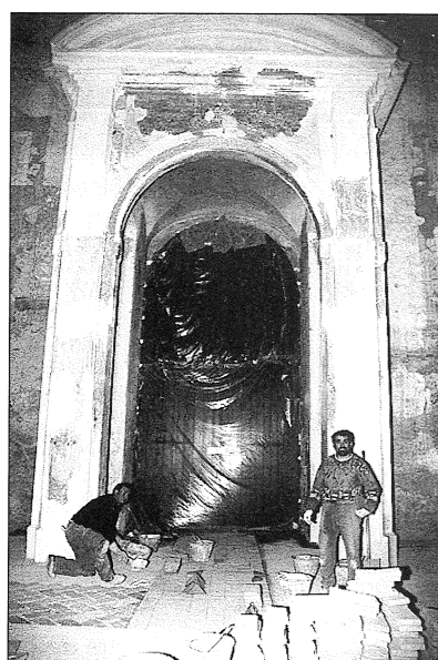
Operai al lavoro sul pavimento
