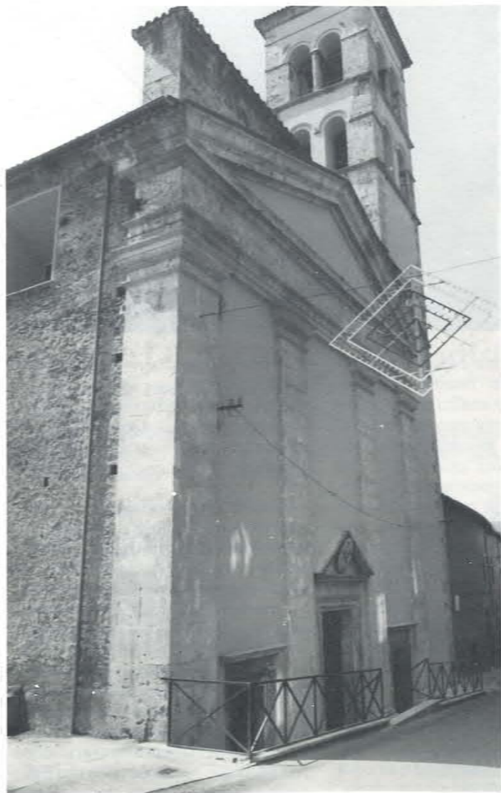
A fianco: la facciata della Chiesa di S. Chiara restaurata; nella pagina accanto: due momenti della cerimonia di riapertura della Chiesa e un particolare del nuovo altare.
