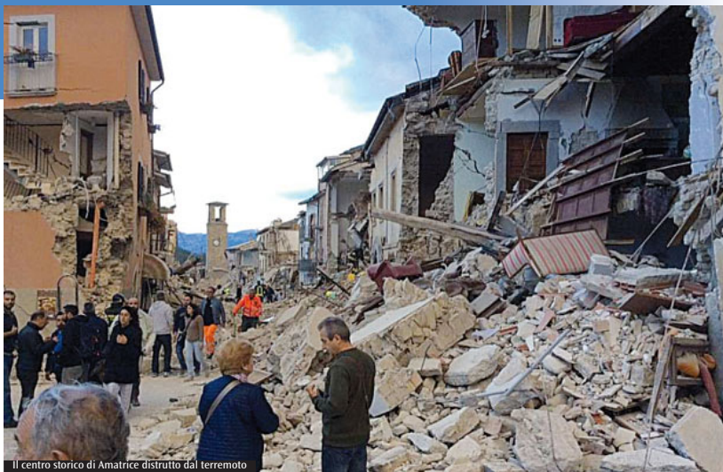
Il centro storico di Amatrice distrutto dal terremoto
