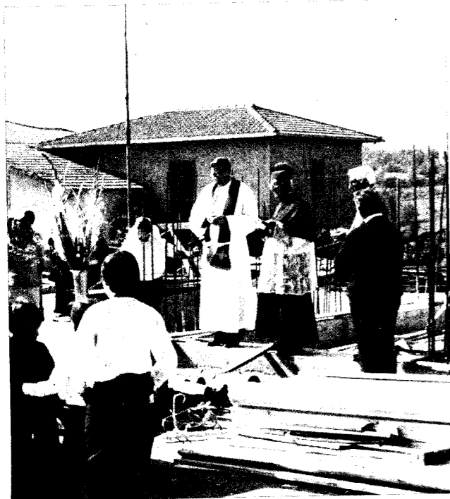
Mons. Amadio benedice i lavori della chiesa di Ornaro.
