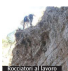
Rocciatori al lavoro
