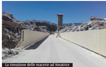
La rimozione delle macerie ad Amatrice
