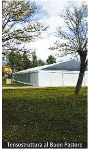
Tensostruttura al Buon Pastore
