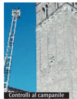
Controlli al campanile
